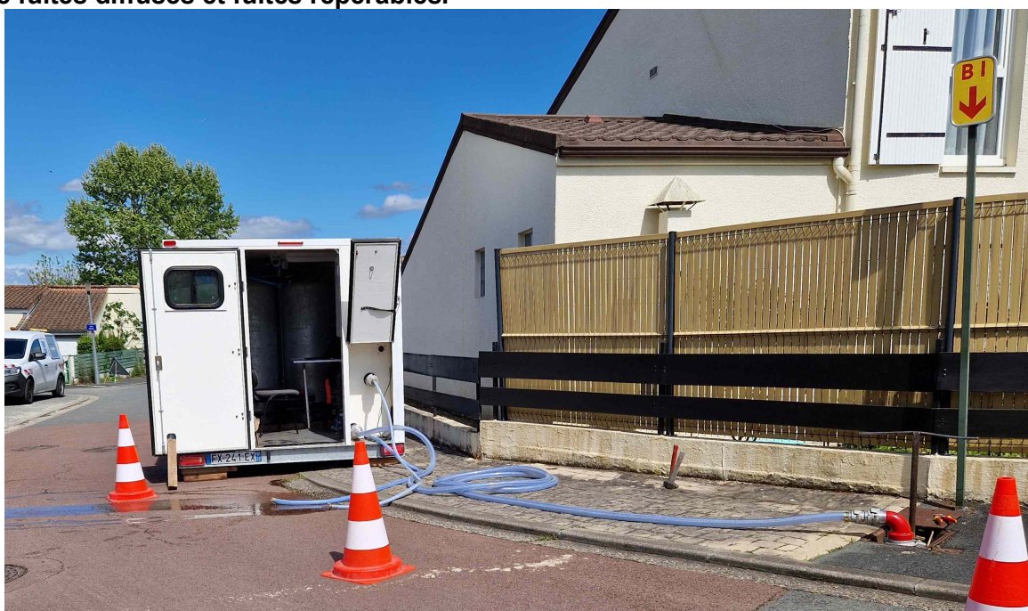
Photo 2 : dispositif mobile de mesure des pertes
