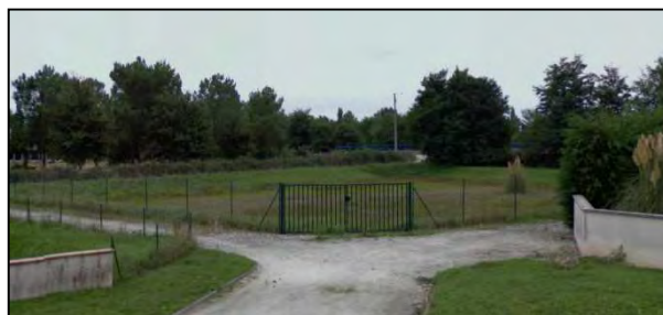
Implantation d'une clôture et d'un portail d'accès
