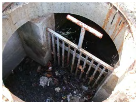
Entretien de l'ouvrage de régulation
