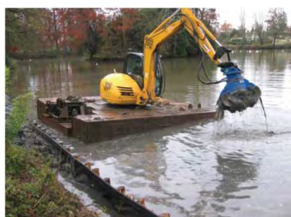
Curage du fond de bassin
