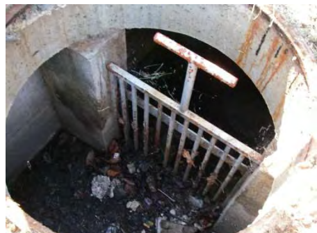
Entretien de l'ouvrage de régulation
