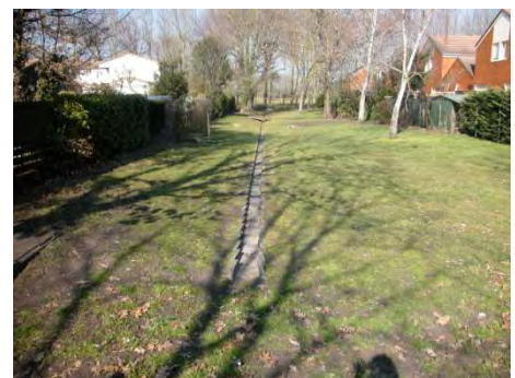
Noues avec cunette Lotissement Villaboïs Rue du Lac à Bruges
