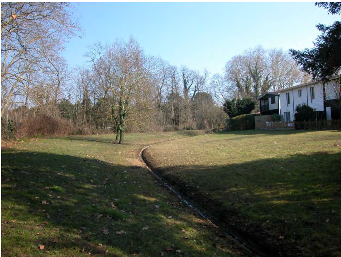
Noues Lotissement Villaboï Rue du Lac à Bruges
