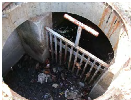
Entretien de l'ouvrage de régulation
