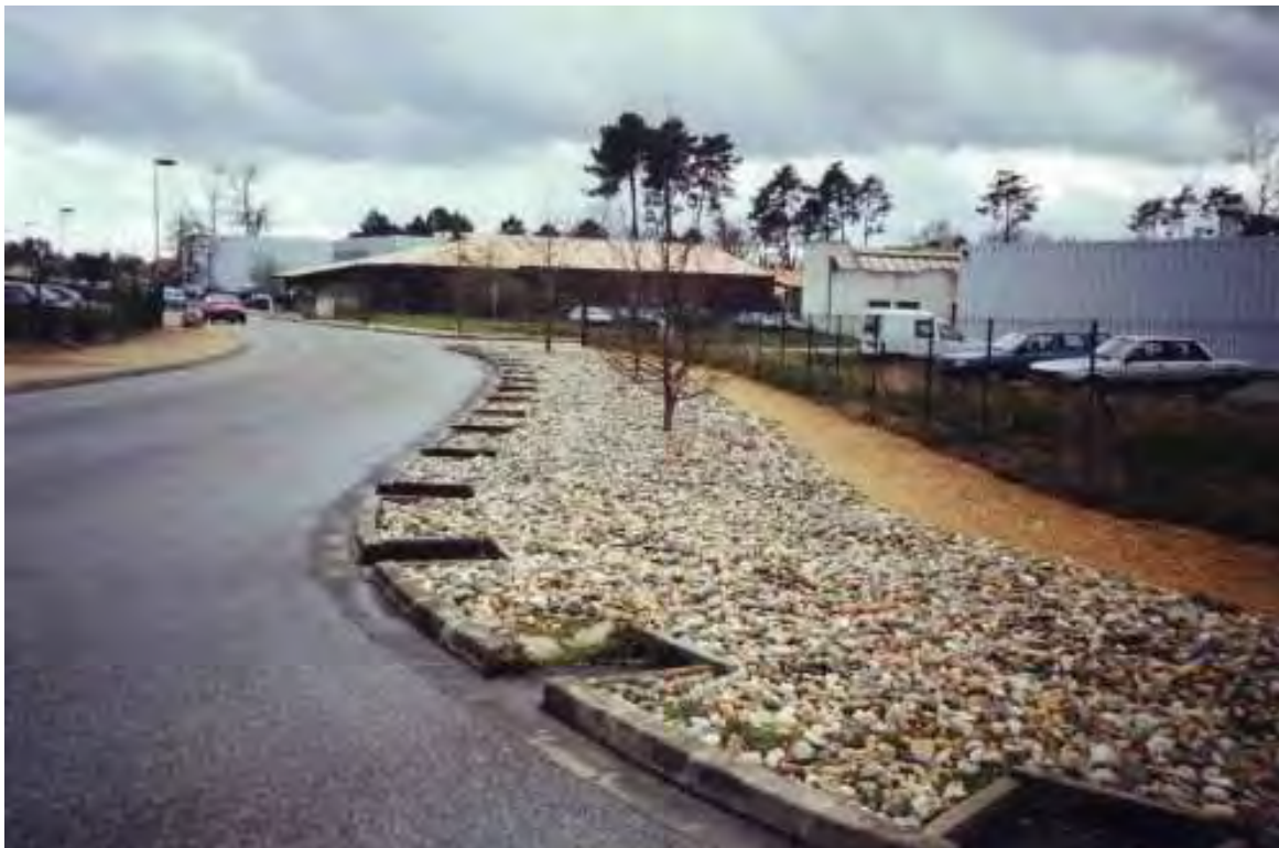
Tranché drainante ZAC de Mérignac + photo de l'avenue de la Grande Lande à Gradignan
