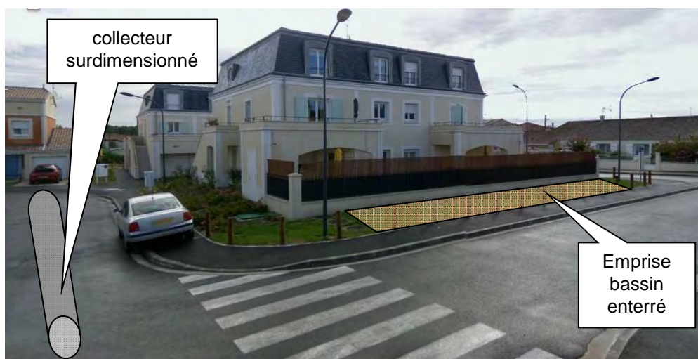
Square du Château rue des Moineaux à Bruges Bassin enterré et Collecteurs surdimensionnés
