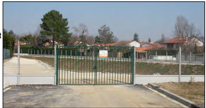
Implantation d'une clôture et d'un portail d'accès
