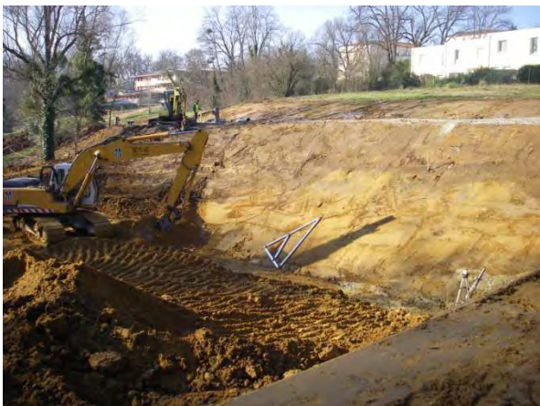
Travaux Terrassement / Remblais
