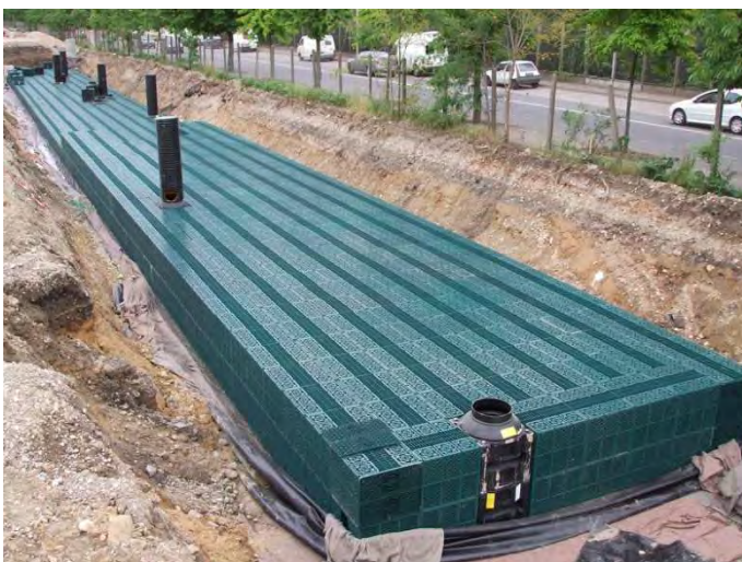
Bassin enterré à structure alvéolaire
