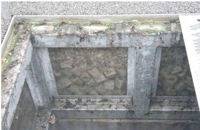
▲ Structure Réservoir (module béton)- Avenue de l'université à Talence
