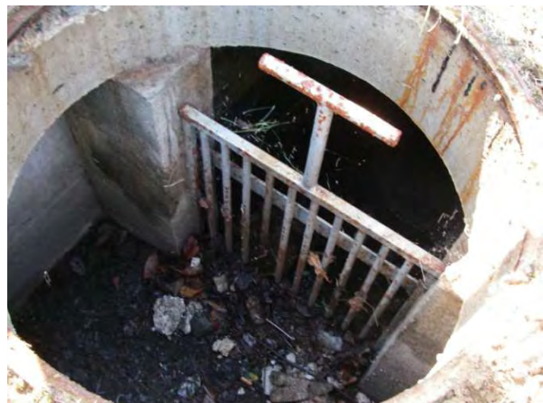
Entretien de l'ouvrage de régulation
