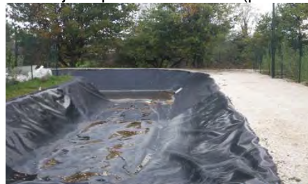
Bassin étanche avec membrane Avenue de la Libération à Ambarès-et-Lagrave
