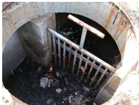
Entretien de l'ouvrage de régulation
